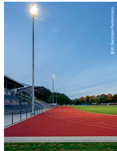
Flächendeckend: 28 Strahler auf 8 Masten.
