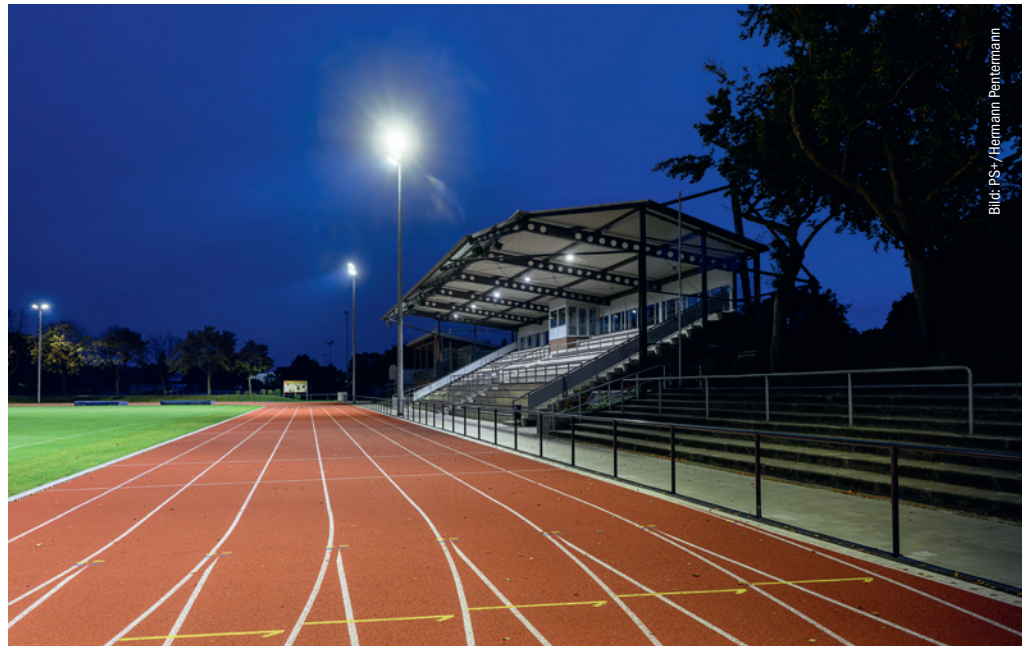
LED-Flutlicht ermöglicht einen Trainingsbetrieb bis in die Abendstunden.
